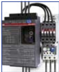
Типовая комбинация «внутри треугольника», заменяющая пускатель по схеме «звезда-треугольник».
